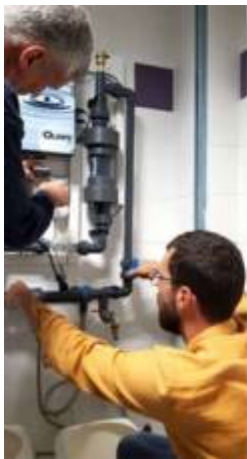
Installation de l'équipement Olimpe Pro au restaurant scolaire de de l'Houmeau
