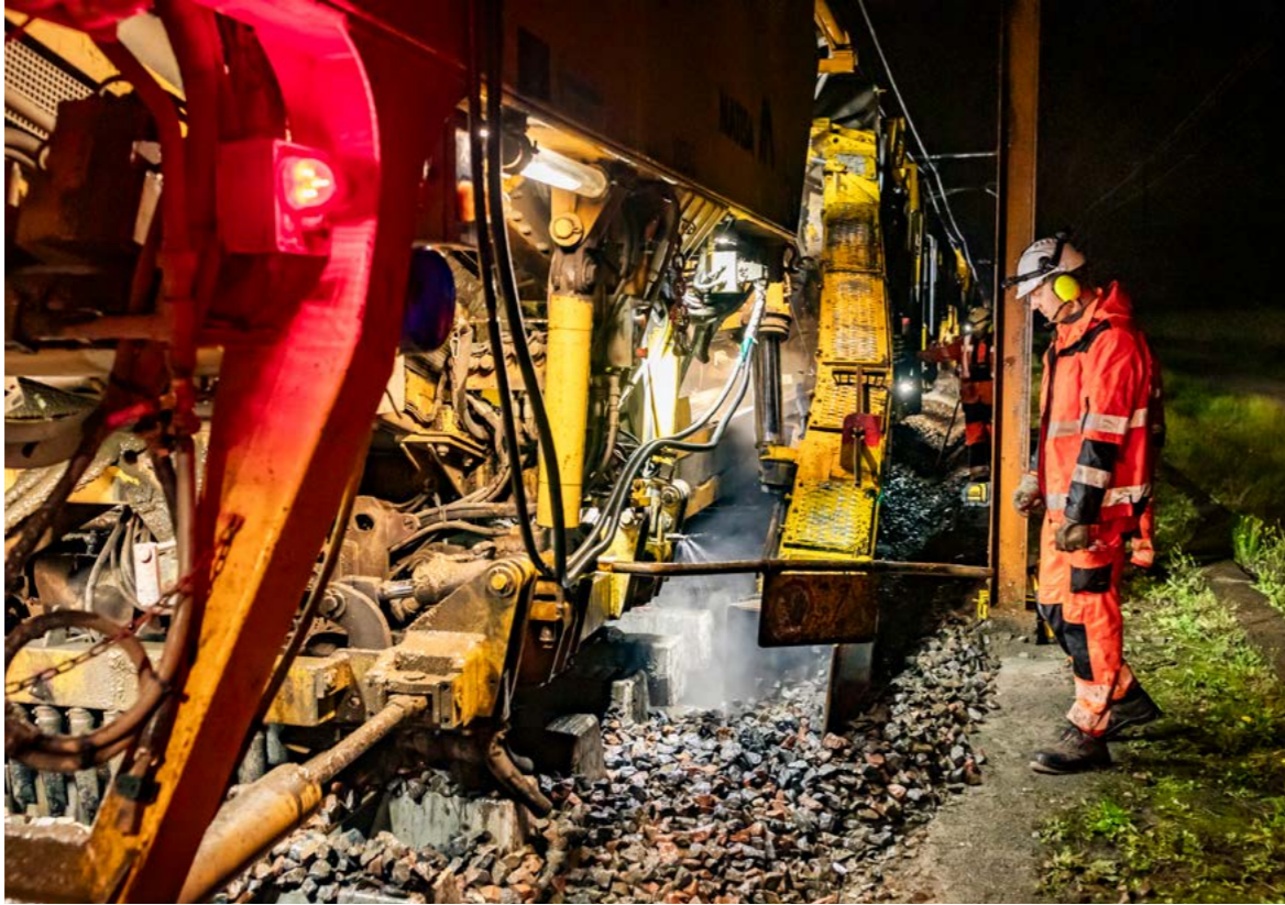
La rampe de dégarnissage permet d'aspirer le vieux ballast afin de procéder à son remplacement.
