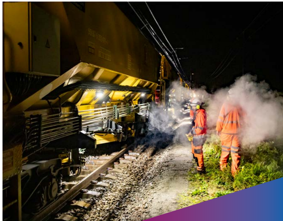
Le vieux ballast est chargé dans des wagons spécifiques.
