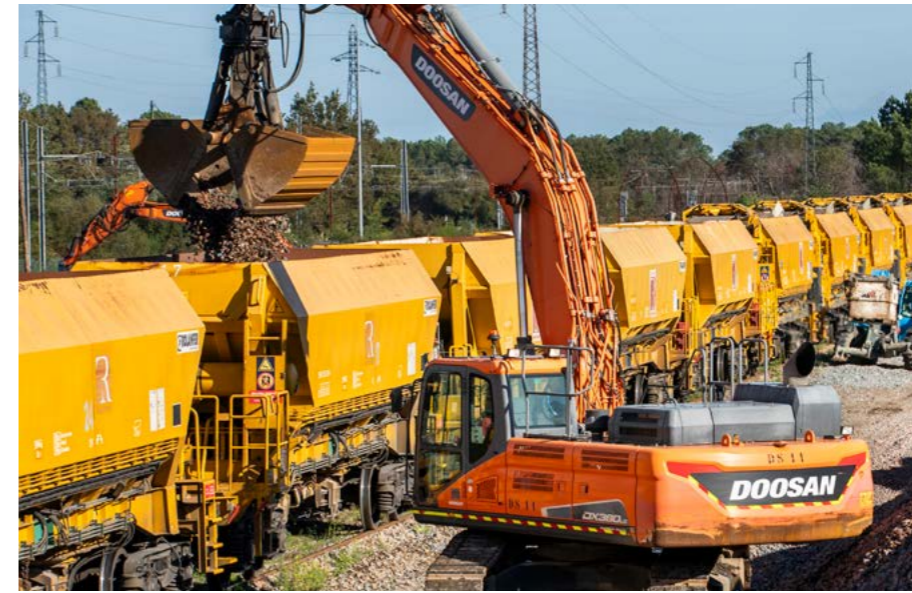
Chargement des ballastières avec du ballast neuf.
