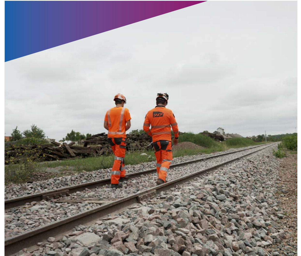
Fin des travaux sur la ligne fret entre Parthenay et Saint-Varent.
