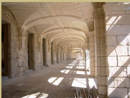
Cloître avant travaux © M. Mauduit, architecte
