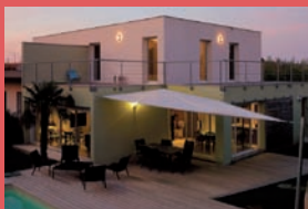
MG+ architecture-maison contemporaine à Saintes
