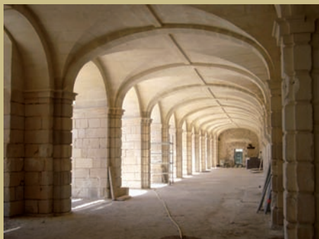
Cloître après travaux © M. Mauduit, architecte
